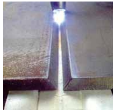
Şekil 1. Seramik altlık kullanılarak yapılan kaynak işlemi Figure 1. A weld application by using ceramic backing
