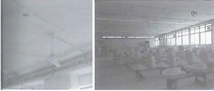
Şekil 1.39 – (a) Geniş kanatçıklı, ancak düşük devirli fanlar; (b) döküm bölümünde kullanılan fanlar
