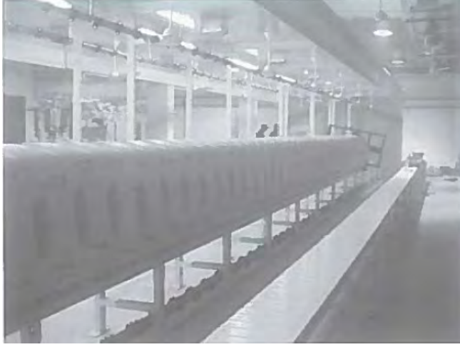
Şekil 1.54 – Döküm tezgâhına kurutucunun yerleştirilmesi
