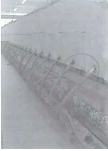
Şekil 1.43 –Operatör döküm borularını kalıp bağlantı elemanına manüel olarak kenetler
